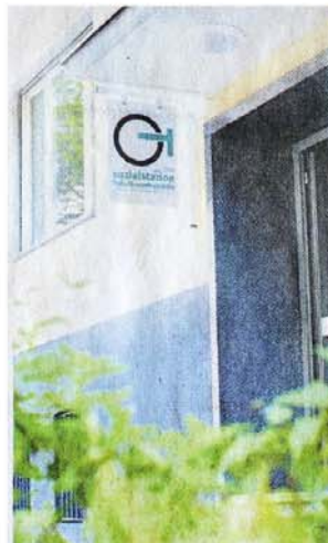
Pünktlich zum 25-jährigen Bestehen wurden die Räume in der Emanuel-Geibel-Straße 18 saniert.
